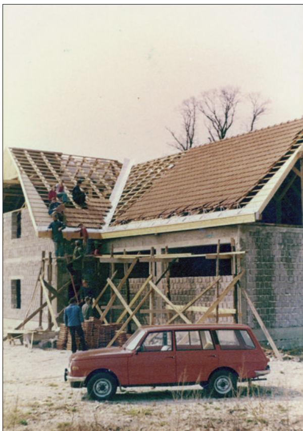
Gradnja večnamenskega objekta, 1980
