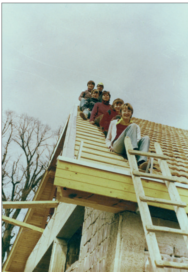
Gradnja večnamenskega objekta, 1980
