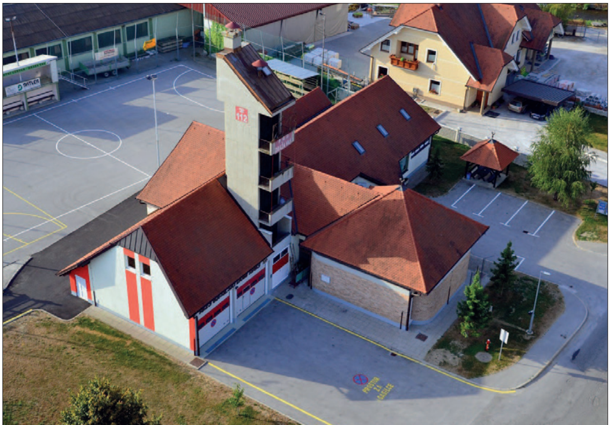
Stavba gasilskega doma PGD Draža vas
