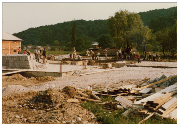
Gradnja večnamenskega objekta, 1980
