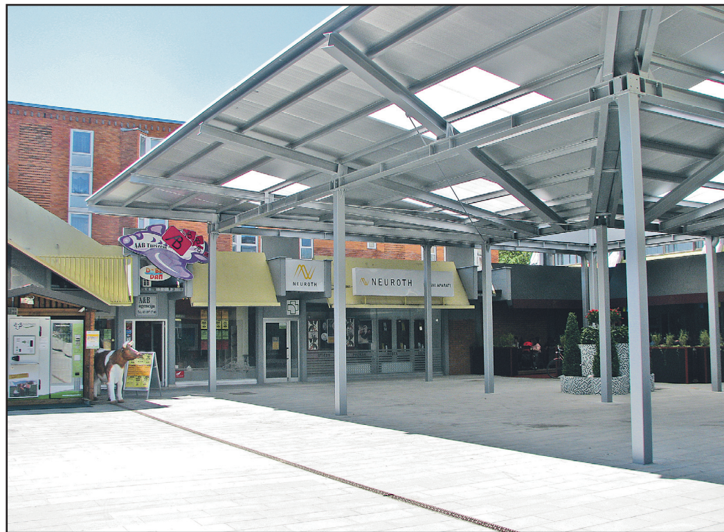
Atrij je precej temen, streha pa je zaradi statike postavljena na več stebrov. Po novem bo to le prireditveni prostor, kmečka tržnica ostaja pod nadstreški Centra Nova.
