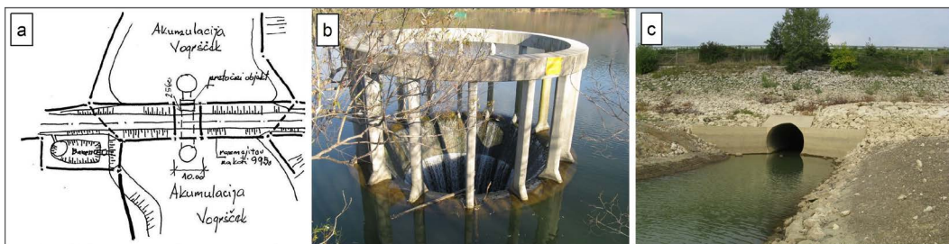
Slika 5: Skica in sliki pretočnega objekta pod HC na odseku Selo–Šempeter, ki povezuje zgornji in spodnji del zadrževalnika. Na skici 5a je viden tudi zadrževalni bazen meteoritnih vod z lovilcem olj. Na sliki 5b je vtok v pretočni objekt, na sliki 5c iztok iz njega na dolvodni strani pod HC (vir skice: Projektna dokumentacija, 1987; foto: Matjaž Tratnik).
