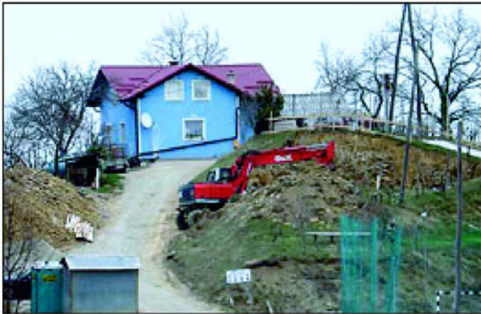
V sklopu del na trasi vodovodnega sistema v Veliki Varnici gradijo tudi že vodohram.
