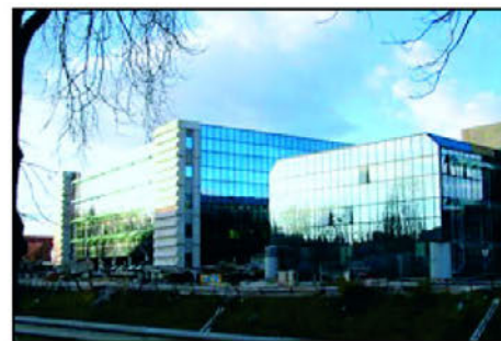
Zgradba Onkološkega inštituta Ljubljana v fazi gradnje
