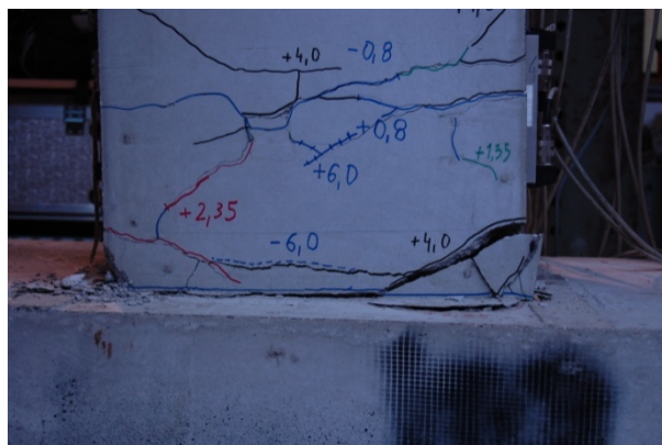
Slika 3.33: Strižni zdrs ob vpetju armiranobetonskega stebra, ki je bil preizkušen na Zavodu za gradbeništvo v okviru projekta SAFECAS (Fischinger et al., 2010c; Isaković et al., 2011; Kramar et al., 2010)
