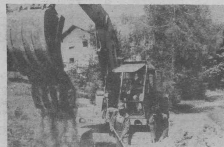
Preizkušnja napeljevala je bila uspešna. Jarek z vodovodnimi cevmi je treba zasuti, opraviti še druga potrebna dela — in krajanje Lipoglava si bodo oddahnili.
