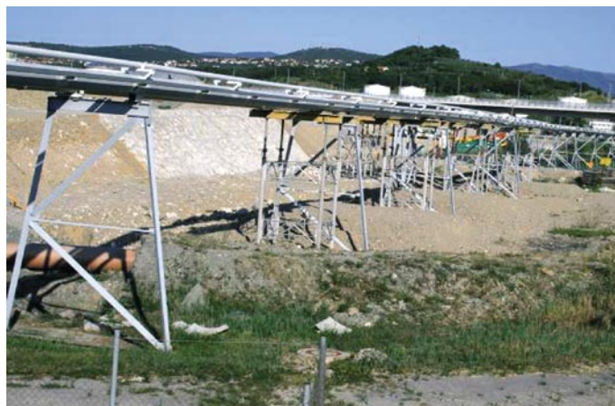
Slika 50 • Nasip cestne navezave Luke na novi vhod je le nekaj metrov oddaljen od glavnega objekta CČN (levo) in od pomembnega in šibko podprtega naftovoda (desno)
