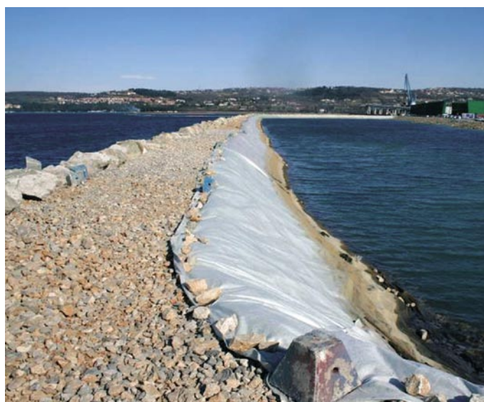
Slika 41 • Lokaciji kaset na čelih pomola I in II (levo) ter s filtracijskim geosintetikom obložena notranja brežina obodnega nasipa kasete na čelu pomola II (desno)
