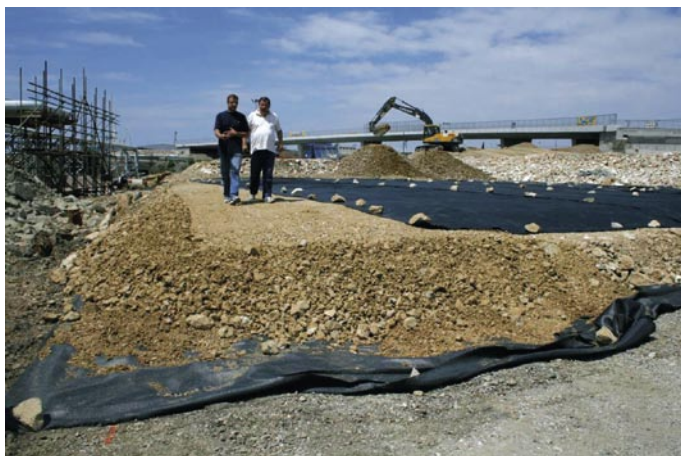
Slika 43 • Armiranje vznožja nasipa, kjer je ta grajen neposredno na mehka tla koprške Bonifike ob obstoječem platoju Luke
