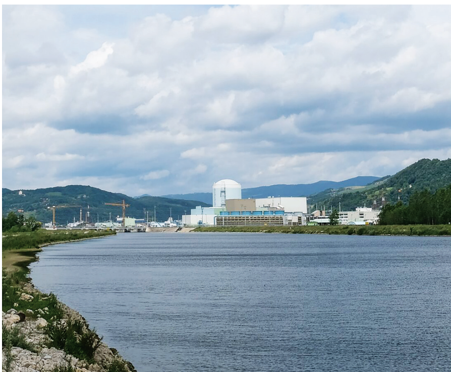
Jedrska energija je največji posamični vir zanesljive in nizkoogljične elektrike v Sloveniji (na sliki: Jedrska elektrarna Krško)
