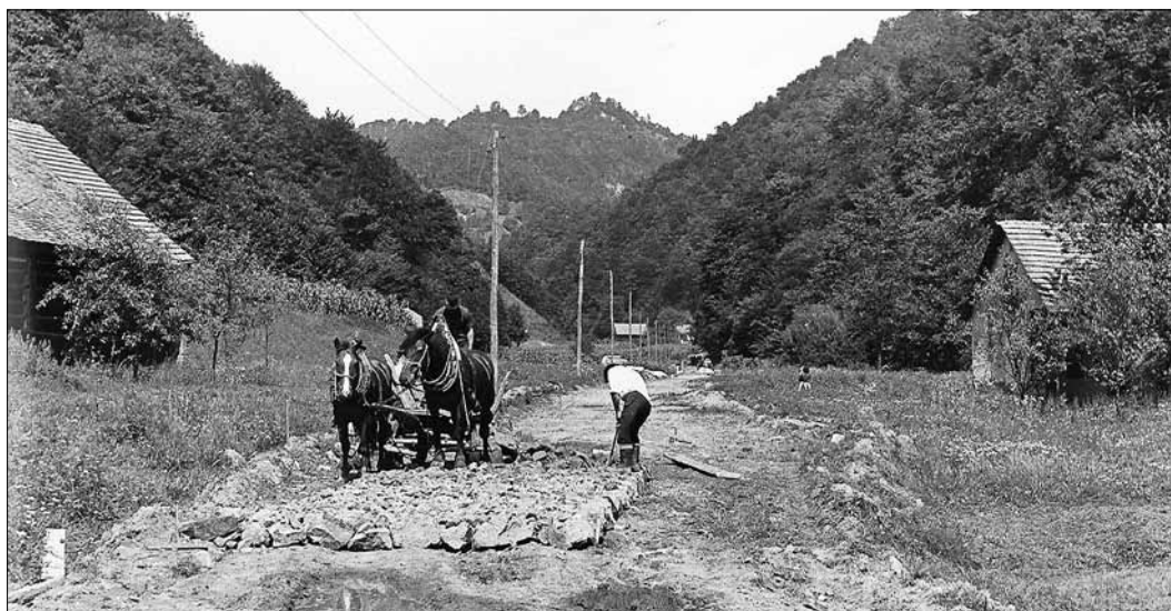
Slika 3: Leta 1969 so v pogorju Maclja zgradili zadnjo cesto po metodi chaussée z odpadlim materialom iz opuščenih kamnolomov.
