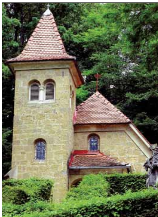
Slika 10: Kapela sv. Ana v Rogoški Slatini je bila leta 1904 zgrajena iz neometanega maceljskega peščenjaka. Figure 10: Chapel of St. Ana in Rogaska Slatina was built in 1904 from unplastered Macelj sandstone
