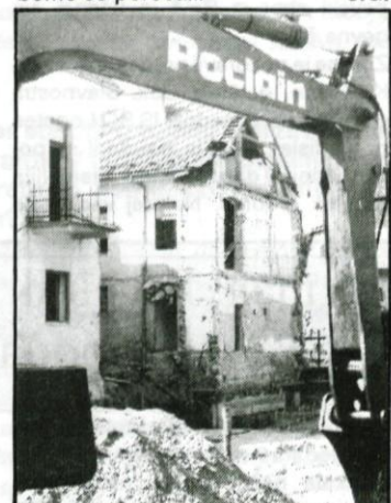
Pripravljalna dela za obnovo sodnije v Gor. Logatcu (foto:J.G.)
