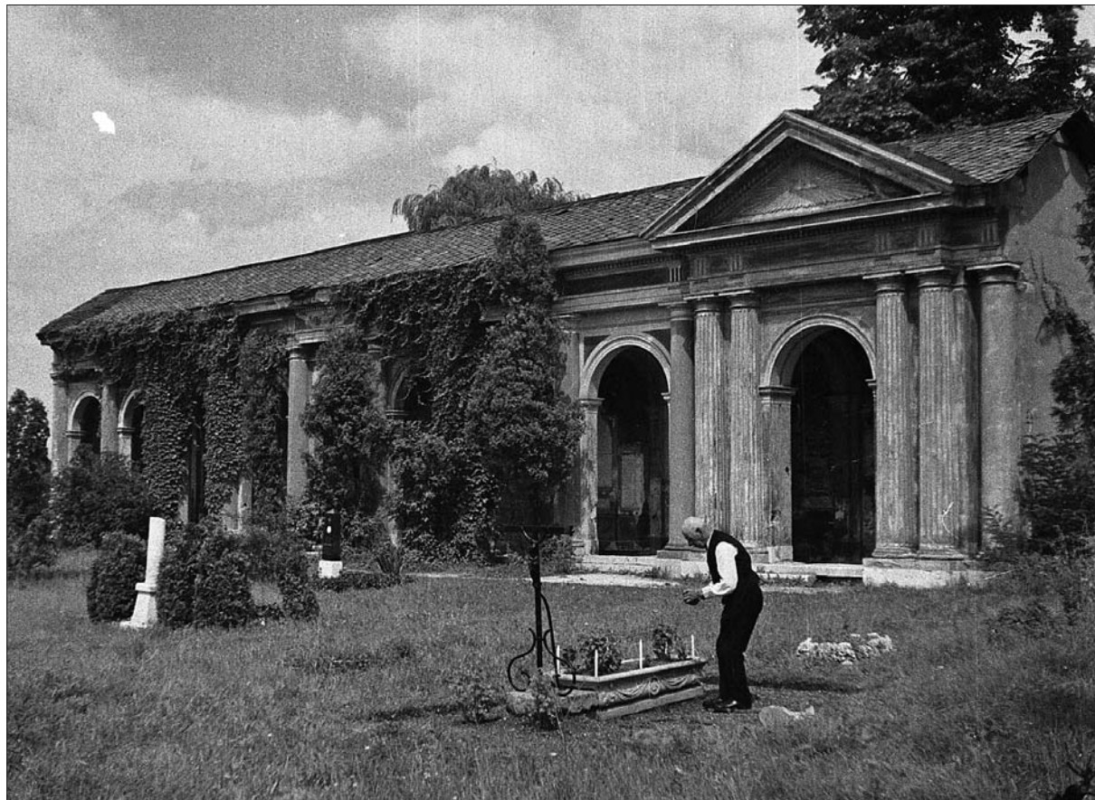
Fotografija dela pokopališča z Arkadami, ki jo je posnel Peter Naglič leta 1934 (SEM, Fotografska zbirka Petra Nagliča, fotografija F_1934_2_2_003).
