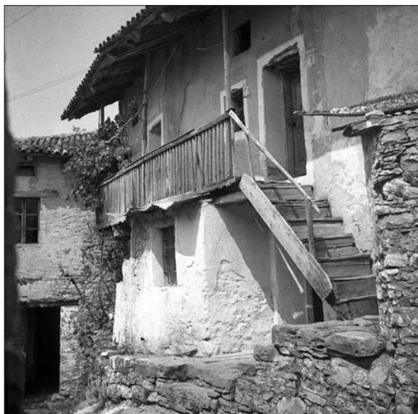
Primer ganka z lesenim zunanjim stopniščem na kamniti podlagi (SEM, Teren 10, 1953).
