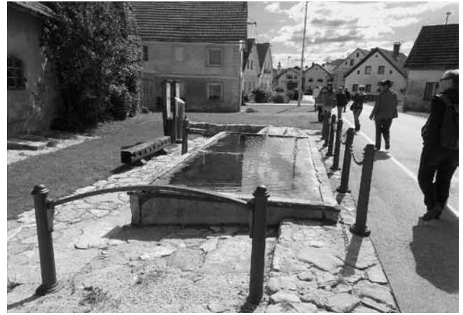
Ogled leta 2013 obnovljene Zgornje štirne v Novi vasi na Blokah. Foto: Eda Benčič Mohar, Nova vas na Blokah, 18. 9. 2014.
