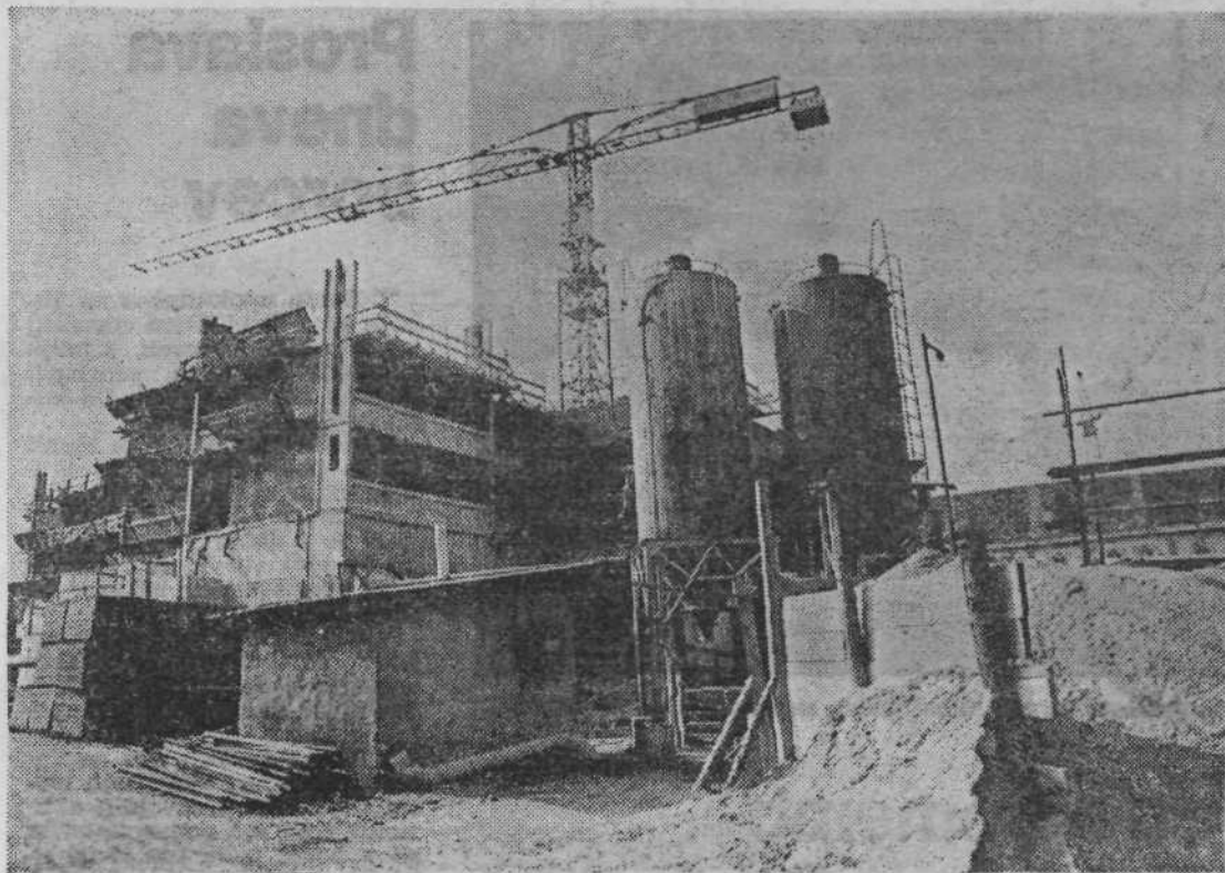
Z enega številnih gradbišč v naši občini: gradnja stanovanj ob Poljanski cesti
