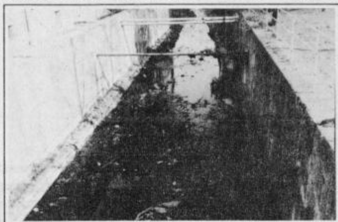
Potok Grajena Ptujčanom gotovo ni v ponos.
