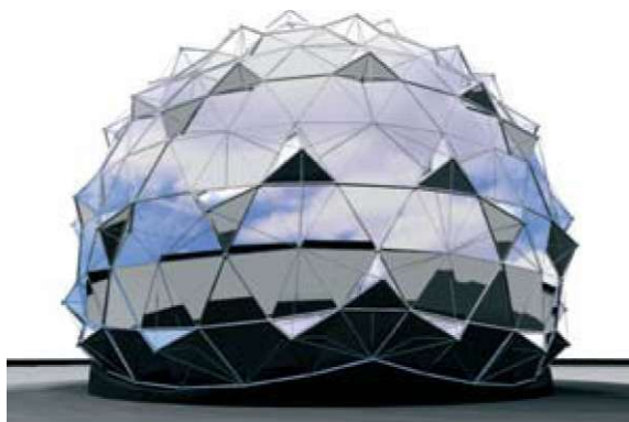
Slika 9: Geodetska kupola projektirana s pomočjo konstrukcije tipa VA(TH) No2 kot stavba laboratorija za CENTRUM Geo, ki je namenjen novemu raziskovalnemu kompleksu wrocławskie Univerze za tehnologijo.
