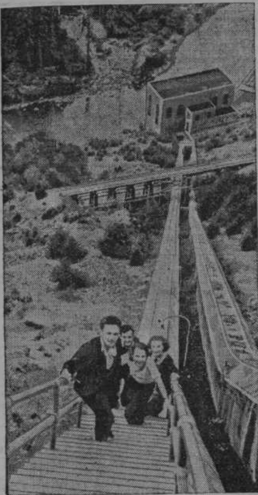
Navzočji slovenski je pri Fortianu v severno-ameriški državi Oregon. 948 stopnic pelje 200 m visoko do elektrarne.
