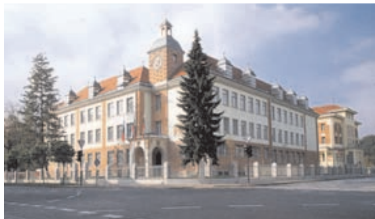
Slika 1: Pogled na kompleks. View of the complex.
