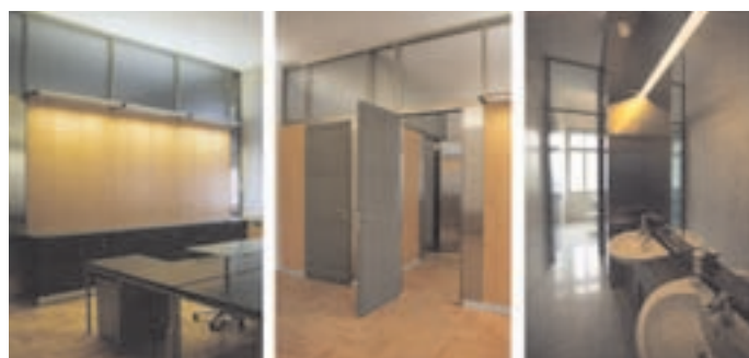
Slika 4: Montažne stene. Partition walls.
