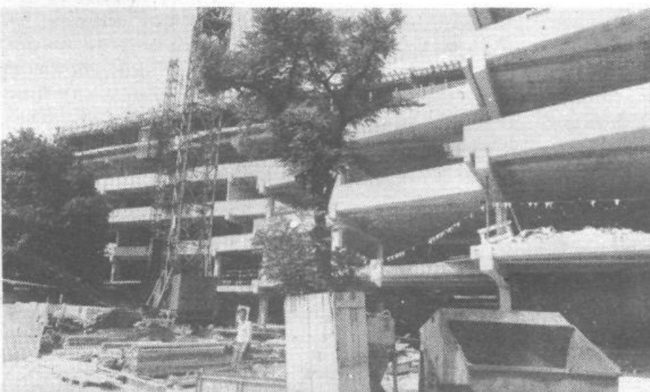
Kje je to in kaj predstavlja? Posnetek je s Tržaške ceste in sicer sta na njem novogradnja Ilirije-Vedroga (nova svečarna in poslovni prostori) ter del gradnje novih proizvodnih zmogljivosti Tiskarne Ljubljana!
