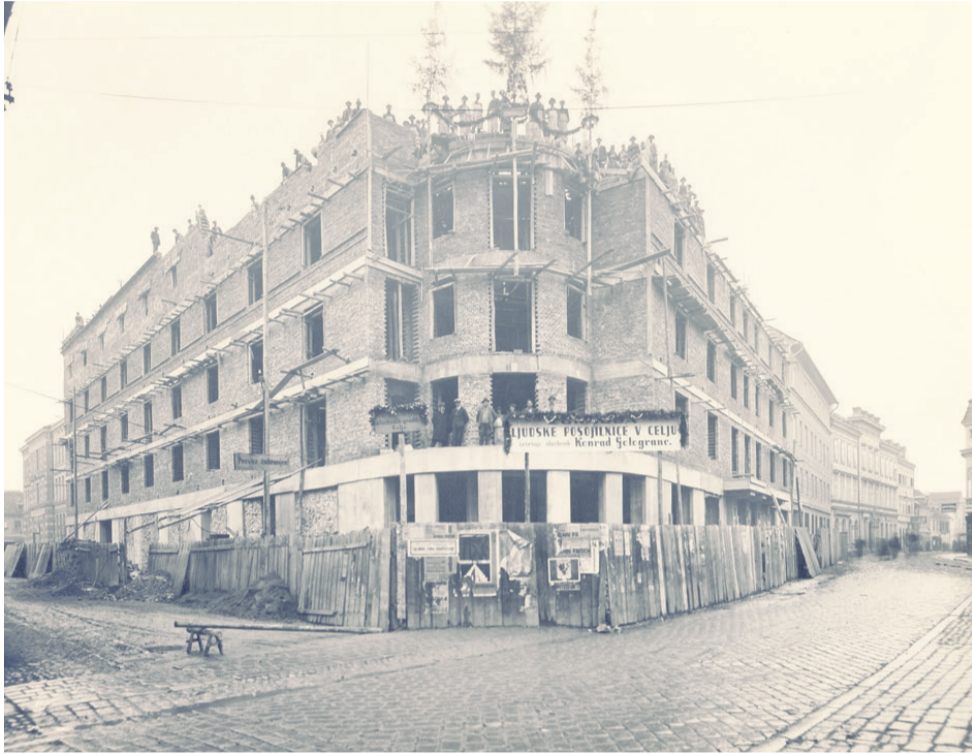
Gradnja posojilnice je potekala pod vodstvom gradbenega inženirja Antona Suhadolca. Dela je izvajalo celjsko gradbeno podjetje Konrada Gologranca. (Foto: MNZC, Pelikanova zbirka)
