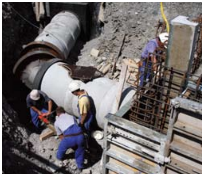
Zaključna dela na priključnem cevovodu.
