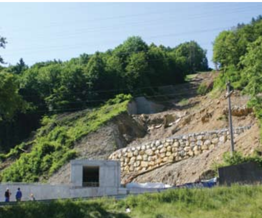
Urejanje hribine pod podzemnim cevovodom.
