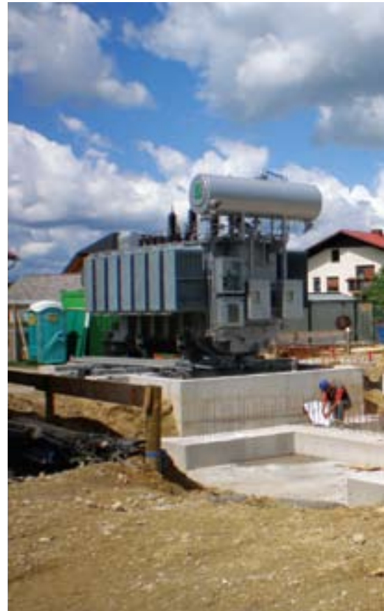
Gradnja 110 kV stikališča v Mokronogu.
