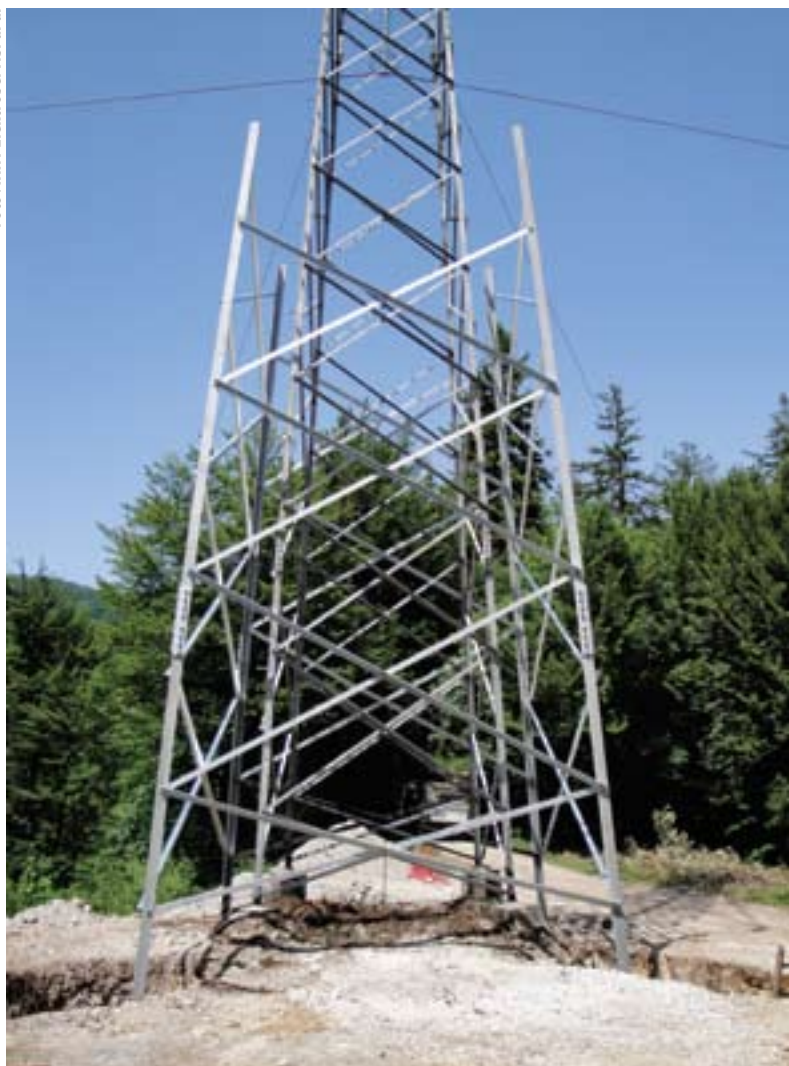
Postavljanje spodnjega dela stebra, medtem ko je daljnovod v obratovanju.
