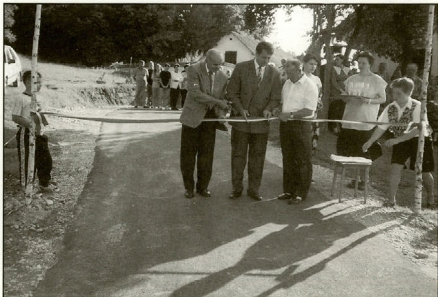
Asfaltna prevleka je zamenjala makadam v skupni dolžini 313 metrov.
