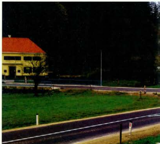
Asfaltiranje in zaključna dela križišča pri Anžiču
