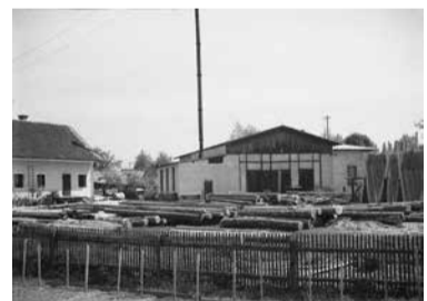
Skokova trgovina in parna žaga z vodnimi turbinami, leta 1932
