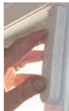
Nameščanje magnetnega tipala na vhodna vrata, ki zazna odpiranje vrat
