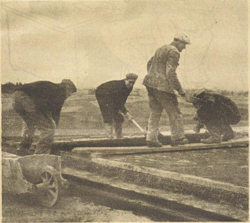
Skupina delavcev pri gradnji hladilnice sadja
