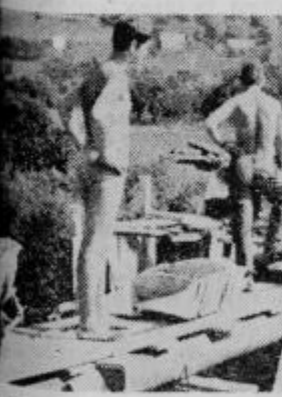
Radin zastoj pri betonirjih, ker so morali najprej izkopati vodo je vzrok koloni
