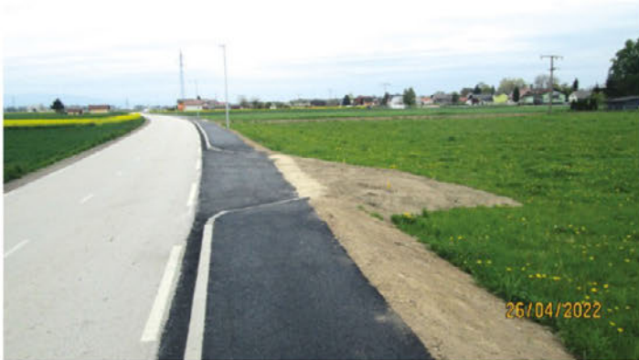
Ob glavni cesti Ptuj–Videm je izgrajen pločnik.
