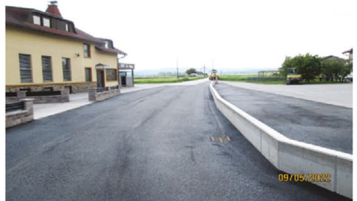
Moderniziran odsek ceste v Pobrežju maja letos
