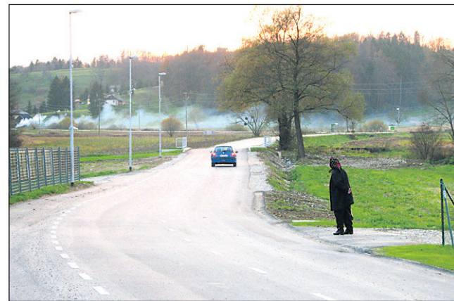
Pri modernizaciji glavne ceste skozi Cirkulane so izvajalci naleteli na precej nepredvidenih težav.
