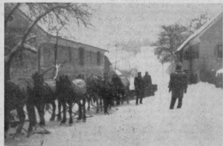
V teh dneh je pluzenje skorajda med najvažnejšimi opravili. Ceste morajo biti prozne in da so, morajo cestni delavci opraviti levji delež dela v nočnem času. Tako smo na našem potovanju proti Vitanju zatekli plug s štirimi pari konjev in delavce pri malici. Ker nismo mogli napredovati zaradi novozapadlega snega, smo se pridružili malici in počakali, da nam je plug očistil pot.
