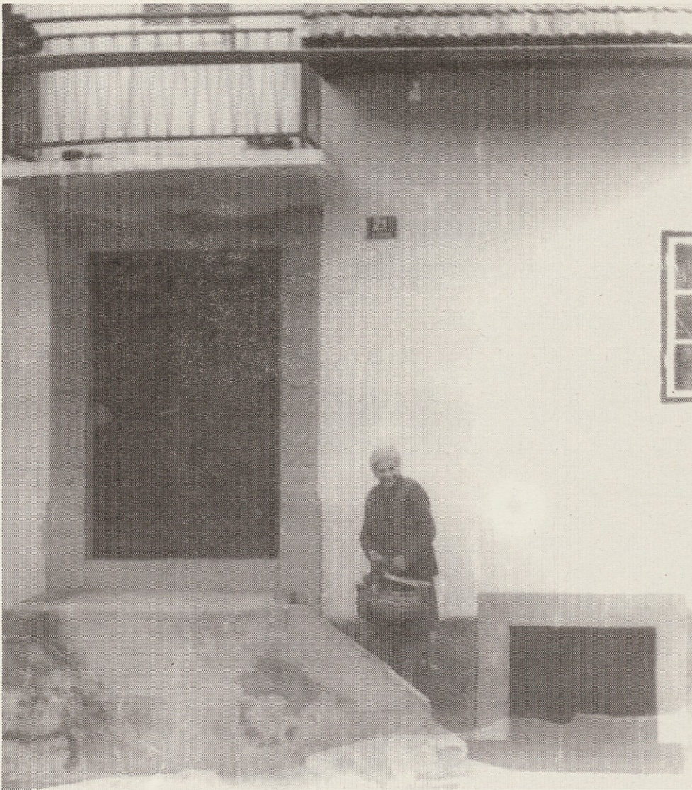
Kamnit portal in lesena vrata pri Čučku v Kovorju
