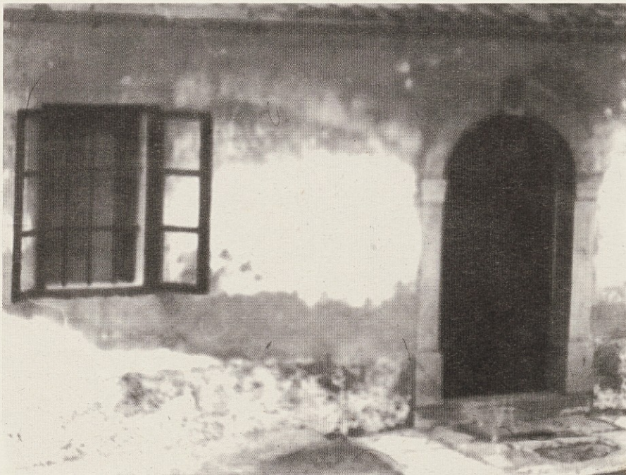
Okno z železnimi križi in portal bivše mežnarije
