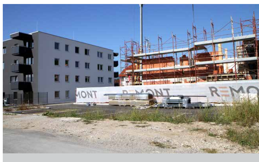
Gradnja 19 oskrbovanih stanovanj se je že začela.
