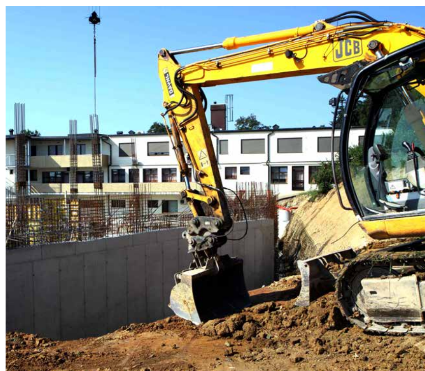
Gradnja prizidka k domu upokojencev na Polzeli
