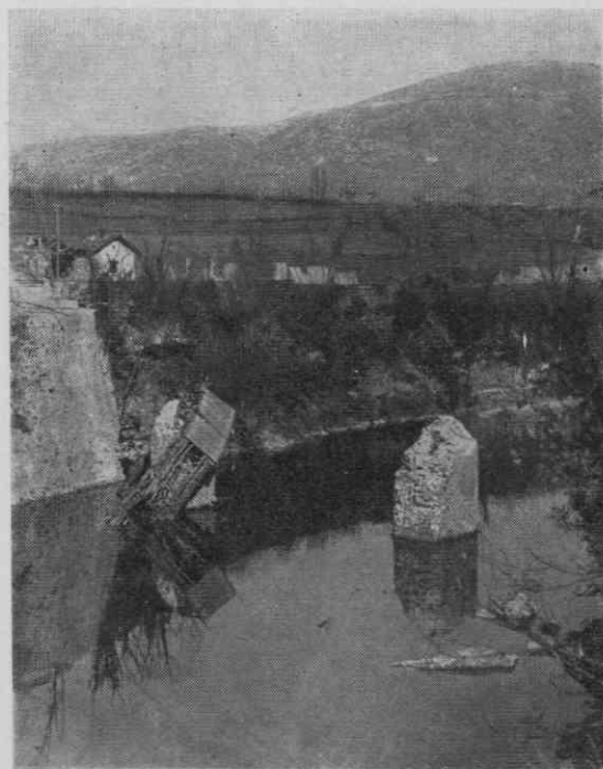
Porušeni most čez Sočo pri Pevmi
