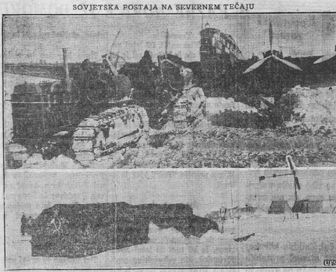
Sovjetski letalci so nedavno postavili na "vrhunec" zemlje postojanko, katere namen je, da se ustanovi stalno postojališče za aeroplane. Spodnji del slike kaže znanstveno opazovalnico, kakor tudi radio oddajno postajo, katera dobiva električno silo potom milina na veter. Na gornjem delu slike pa se vidi traktor za prevažanje aeroplanov.
