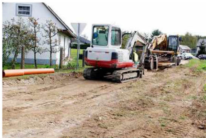
V teh dneh se je začela izgradnja kanalizacijskega omrežja z zamenjavo vodovoda v naselju Pobrežje (Boršt) v dolžini 290 m.
