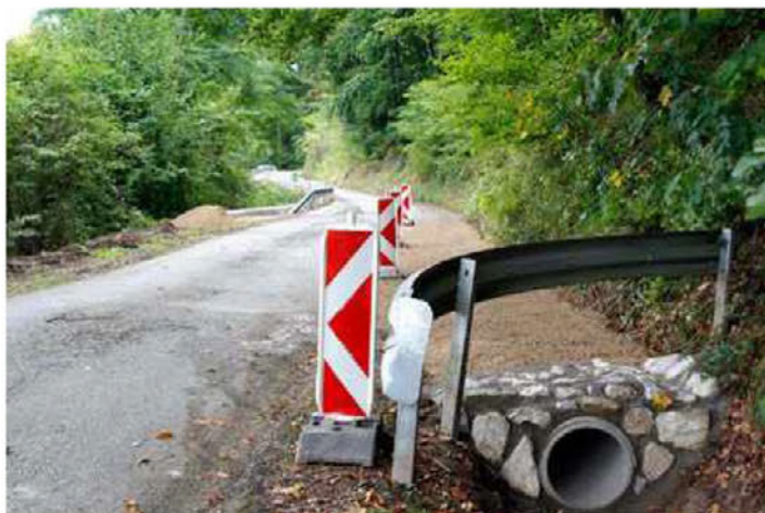
Sanacijska dela na cestnem odseku Vareja–Fošnice
