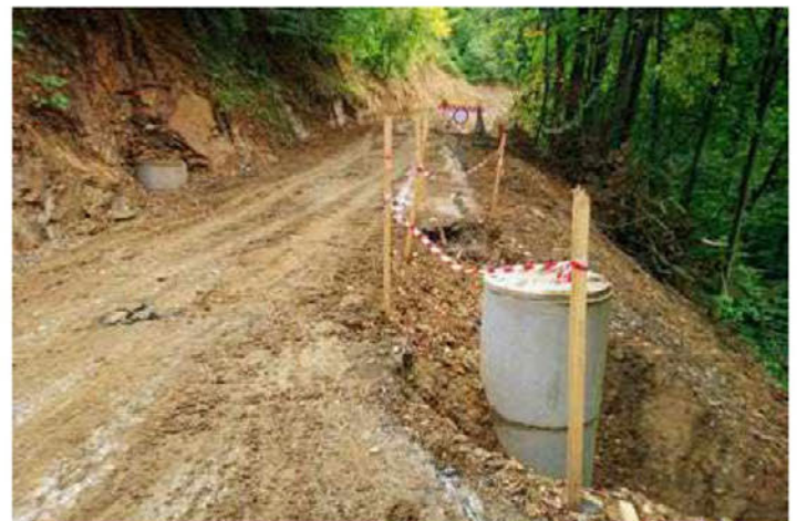
Vgrajenih bo 47 zadrževalnih armiranobetonskih pilotov, dolgih kar 11 m.
