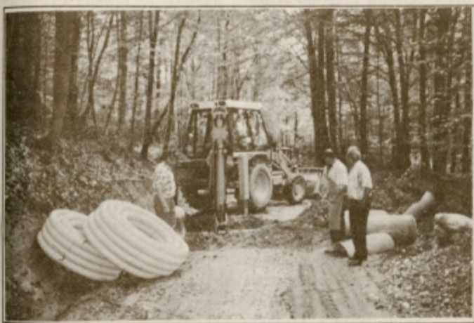
Drsteljčani pri pripravljanih delih na cesti.
