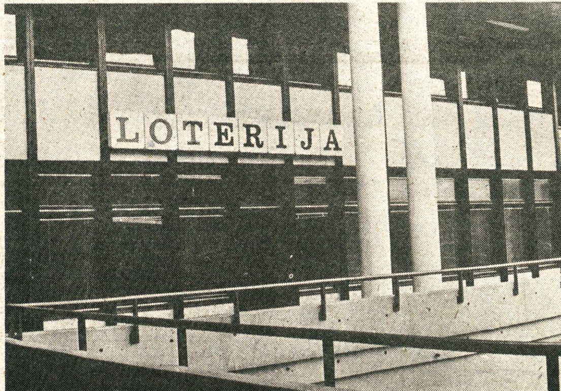
Tudi Loterija bo dobila svoj prostor v novi zgradbi. (FOTO: T.B.)
