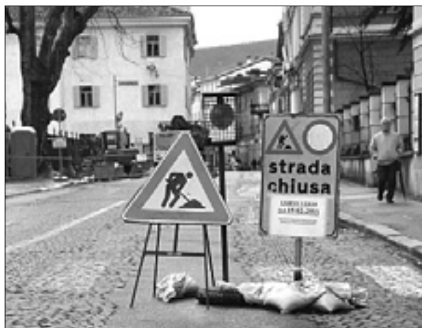
Prometna zapora na Verdijevem korzu
