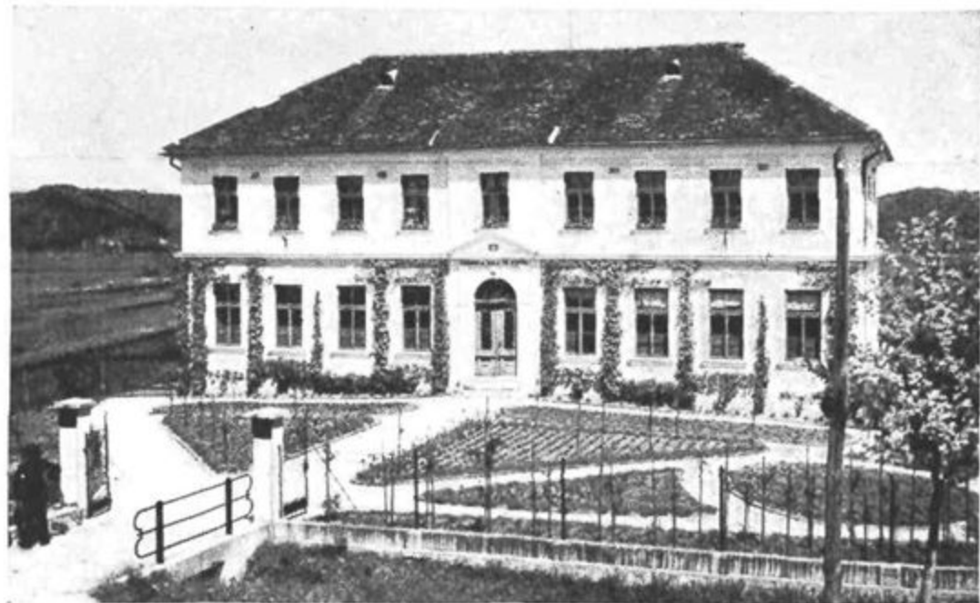
Šolsko poslopje na Barju, sezidano po potresu l. 1895.
