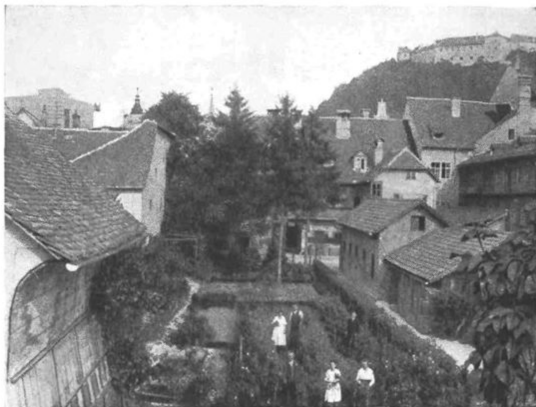
Nekdanja Primčeva hiša v Wolfovi ulici 6 in vrt z zapada
