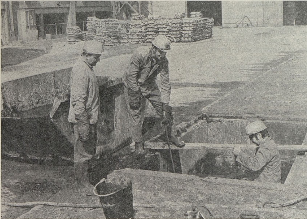
Čiščenje pretočne greznice pri pralcih plina
