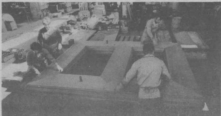
V Energoinvestu na Črnučah bodo letos za 30% presegl lanski fizični obseg proizvodnje. Na sliki: postopek zlaganja jedra transformatorja tip RT 31,5/31,5/21 MVA 110/36, 75/21 kV za Prištino. Jedro je napravljeno iz 11.400 kosov pločevine vrste hipersil m 4 (iz voza) debeline 0,3 milimetra in tehta 18.400 kilogramov.
