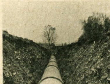
Kanal kolektorja je iz azbestno-cementnih cevi profila 800 mm, spajan vodotesno s posebno tehniko spajanja
