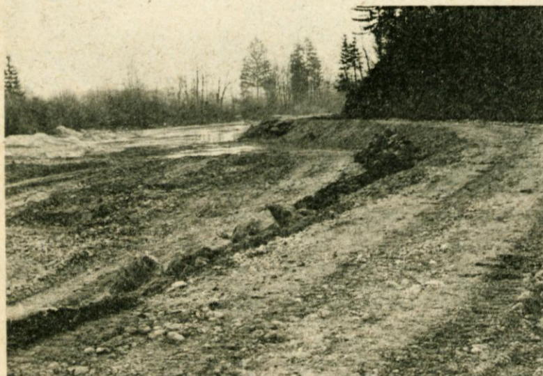
Trasa kanala okrog homškega hriba je najzahtevnejši odsek celotne trase. Teren je živa skala, poleg tega pa dela potekajo v vodi
