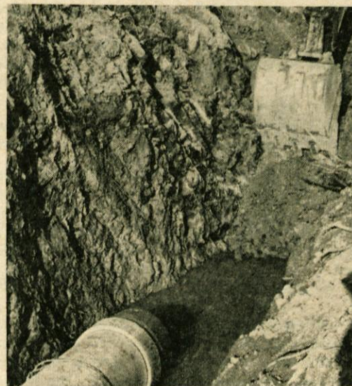
Vodna skupnost Ljubljana-Sava izvaja za homškimi hribom v dolžini 220 m obrežnega zavarovanja v sami strugi Kamniške Bistrice
