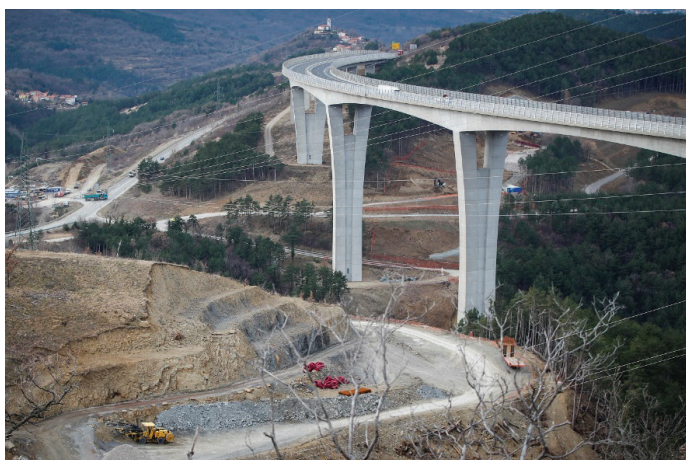
Slika 7. Predvkop predora Beka (T2) na območju Črnega Kala, v ozadju priprava delovišča viadukta Gabrovica in deponija Bekovec.
