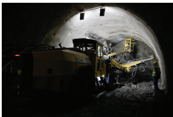
Slika 10. Gradnja predora Mlinarji (T7).
