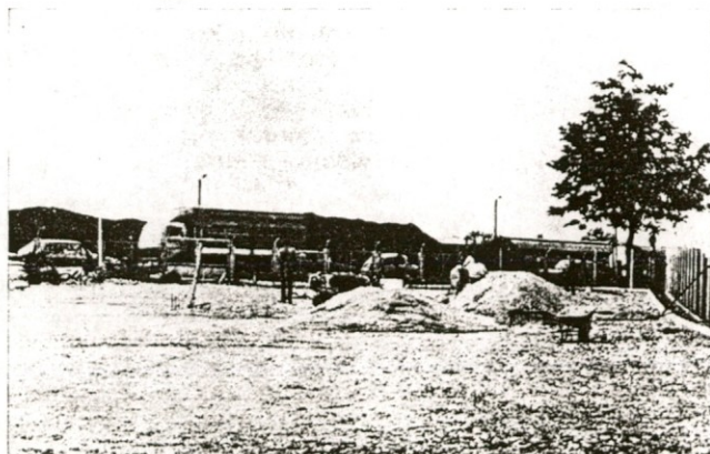
Dela pri urejanju parkirišča in kolesarnice potekajo počasneje kot smo pričakovali
