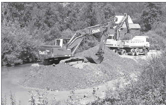
Odstranjevanje naplavljenega proda (Foto: LM)
