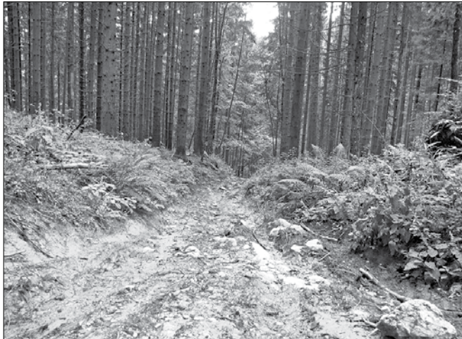
Gozdne vlake morajo biti prekopane, da preprečimo erozijo.
