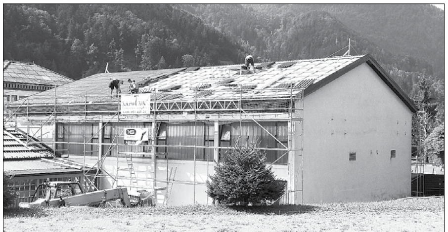
Izvajalci so zamenjali kritino, uredili dodatno izolacijo, zračni most in na novo podeskali streho. (Fotodokumentacija Občine Gornji Grad)
