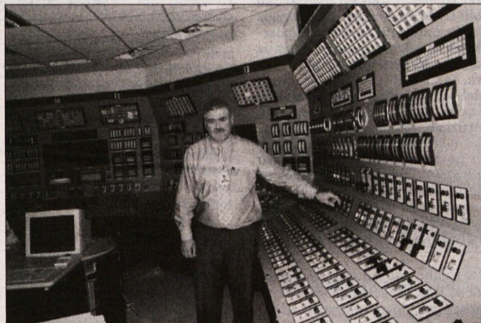
SIMULATOR - Medtem ko je Jedrska elektrarna Krško v preteklosti pošiljala svoje operativno osebje na usposabljanje drugam, začenja z letošnjim letom strokovno vadbo doma. V ta namen je postavila simulator, ki je na pogled in z opremo natančna kopija komandne sobe elektrarne. V simulatorju udeleženci izobraževanja podrobno proučujejo posamezne tehnološke postopke v nukleariki vključno z ukrepi ob morebitni nesreči v elektrarni. Maja bodo v Krškem na omenjenih napravah začeli usposabljanje prve skupine strokovnjakov. Na fotografiji: v simulatorju (ko so tam potekala zaključna montažna dela) Franc Pribožič, v jedrski elektrarni Krško vodja strokovnega usposabljanja. (Foto: M. Luzar)
