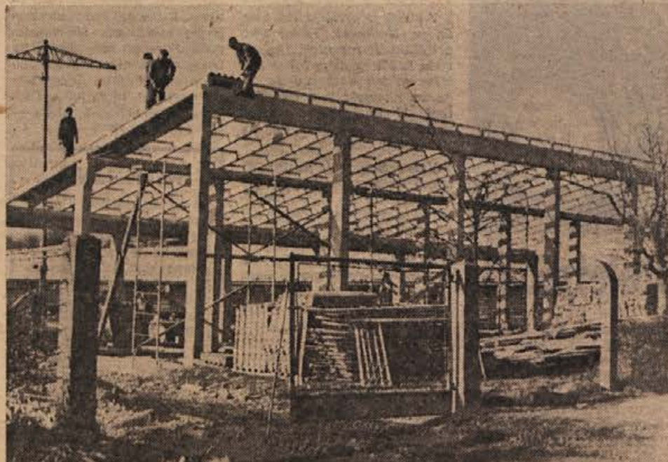
V Rosalnicah so letos začeli graditi svojo mehanično delavnico, ki bo sposobna opravljati vsa popravila
