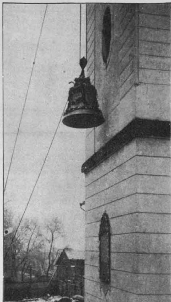
Novi zvon v Braslovčah dvigajo v zvonik.
