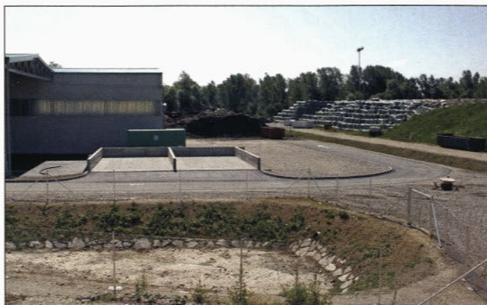
V ospredju ponikalnik čistih vod, za njim biofilter in hala za naknadno zorenje komposta.
