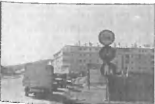
Ljubljanska cesta: pločnik - ga ni; kolesarska sleza - porušena, za motoriste prepovedana; zemeljska cesta - gradbišče neoznačeno
