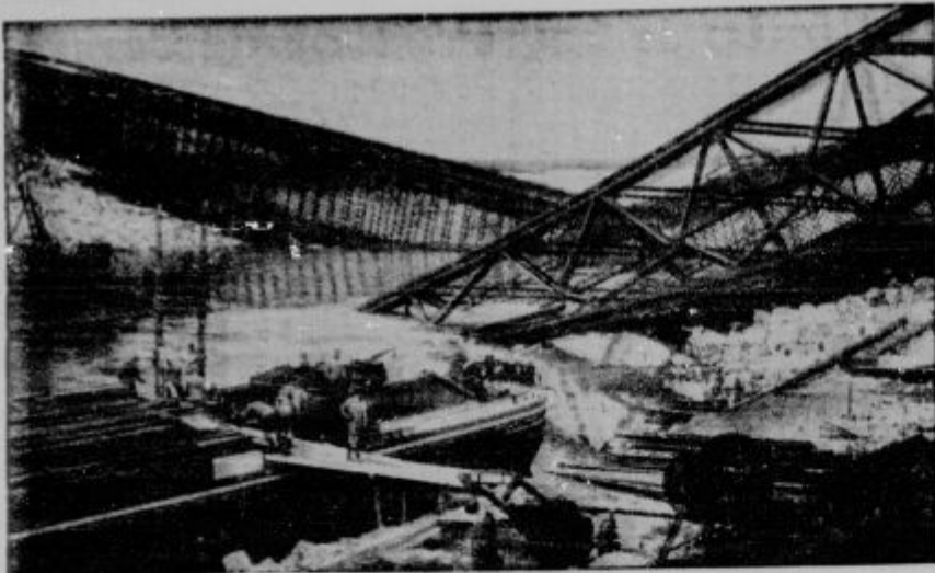
Nemški pionirji popravljajo železniški most, ki so ga razrušile poljske čete
